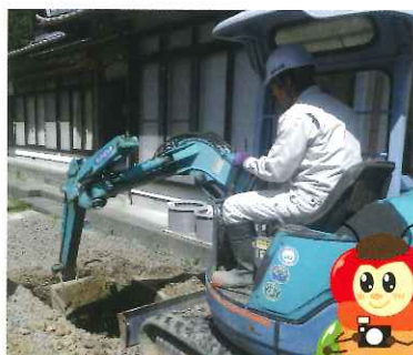
▲自ら掘削作業を行う川口さん
