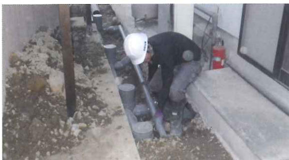
▲汚水配管の切り替え作業の様子
