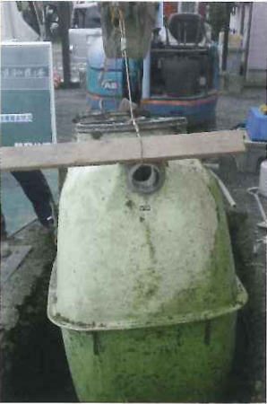
Before 掘り出した単独浄化槽
