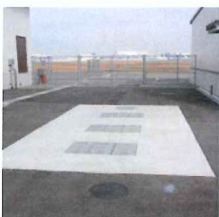
▲センターに設置されている浄化槽
