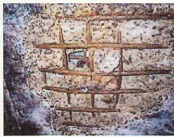
鉄筋が露出した管路
