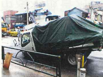
管渠腐食による道路陥没
