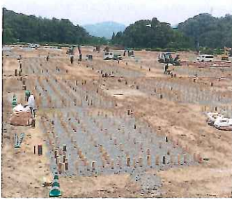
▲仮設住宅の建設がスタートした頃の現場(城南地区)
